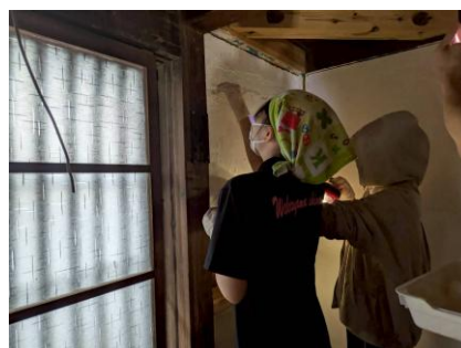
写真7 ヘラを使って端を塗る場面
