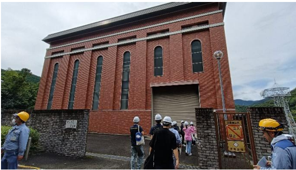
図7 新高津尾発電所
