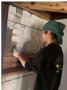
写真4 土壁をローラーで塗る場面①
