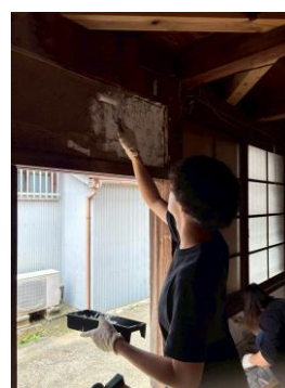
写真5 土壁をローラーで塗る場面②
