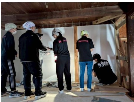
写真2 板壁にローラーで珪藻土を塗る場面
