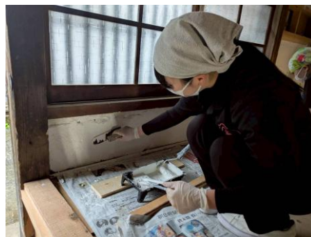
写真3 土壁にコテで漆喰を塗る場面
